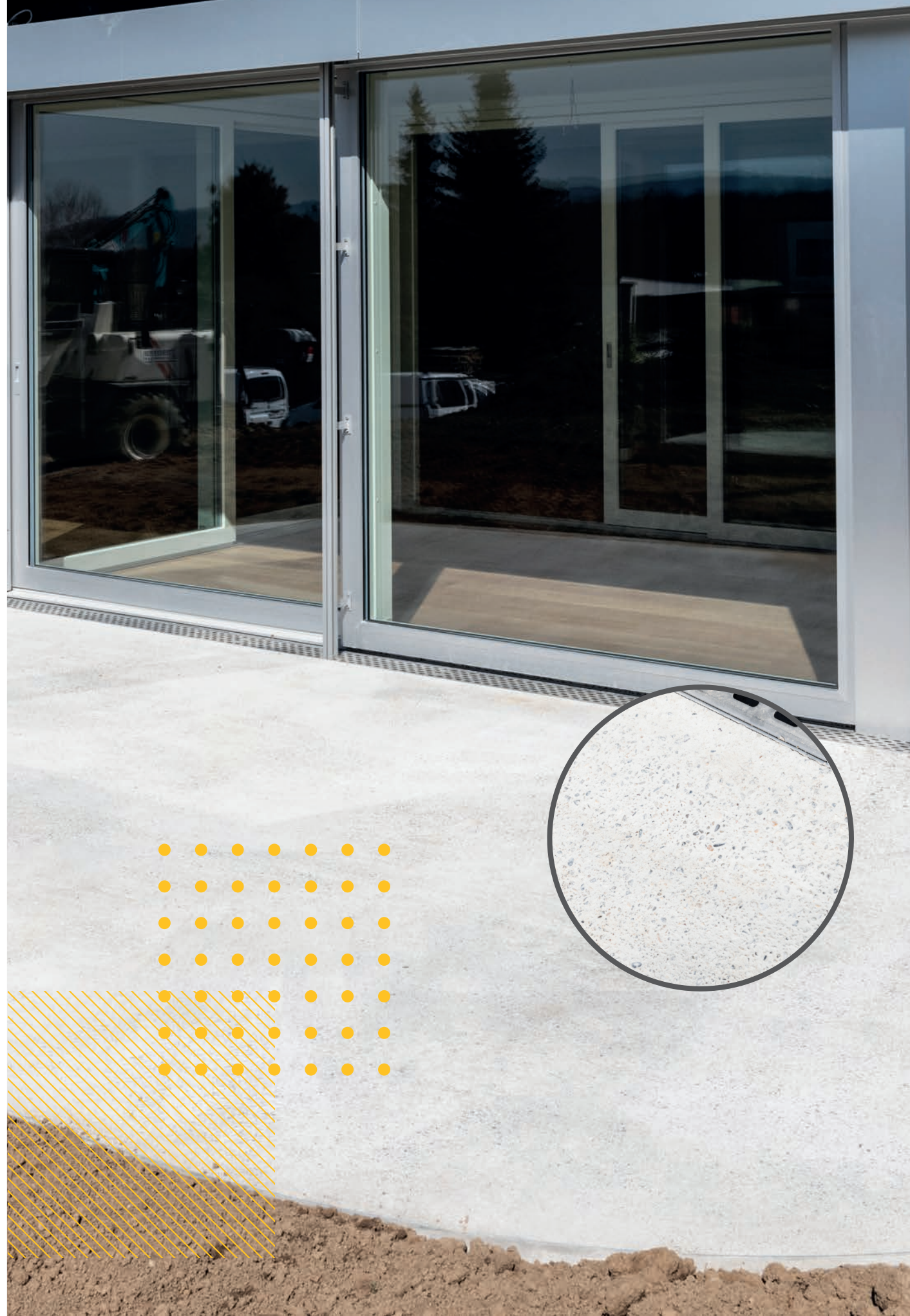
WASCHBETONPLATTE BOTTMINGEN, SPITZACKERSTRASSE Oberfläche mit Lammfellroller abgerollt um Steinkorn zum Vorschein zu bringen
