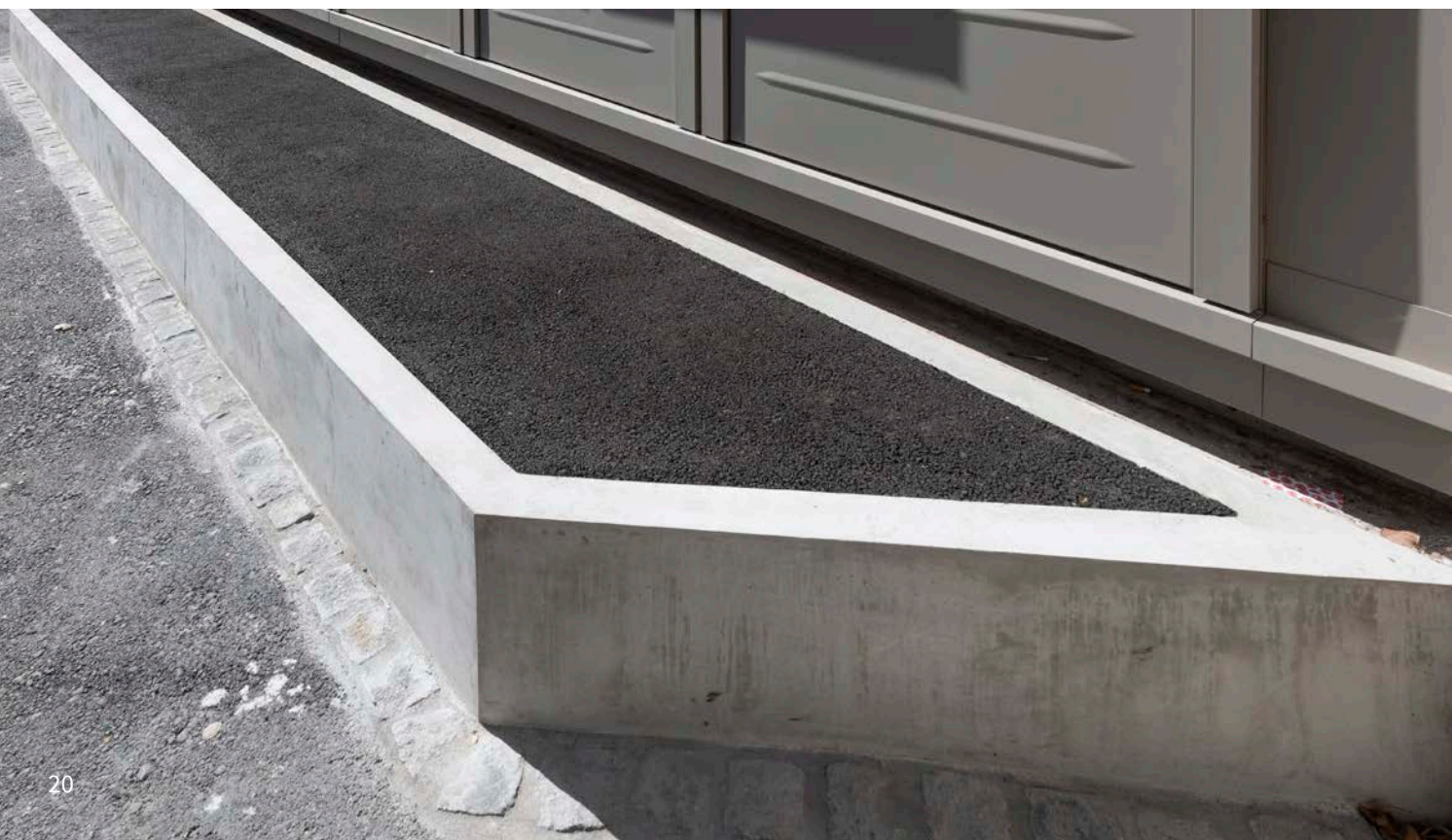
SITZBANK BETON&BELAG / GYMNASIUM MÜNCHENSTEIN Sichtbeton-Einfassung und nachträgliches Asphaltieren
