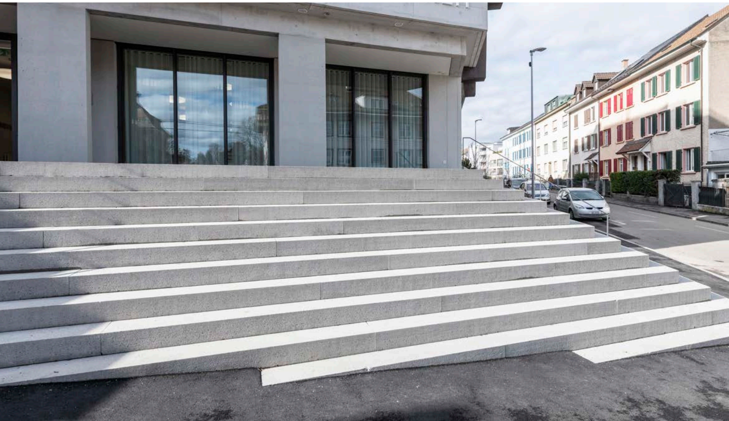
BLOCKSTUFEN SETZEN / HAUPTSTRASSE 34, BINNINGEN Blockstufen/Fertigelemente versetzen
