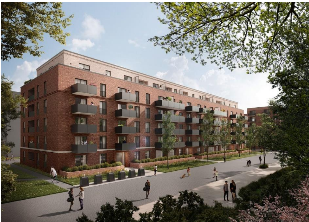
Quartier Turley, Mannheim : Construction d'un nouveau quartier résidentiel durable (image : © bloomimages GmbH, Hambourg).
