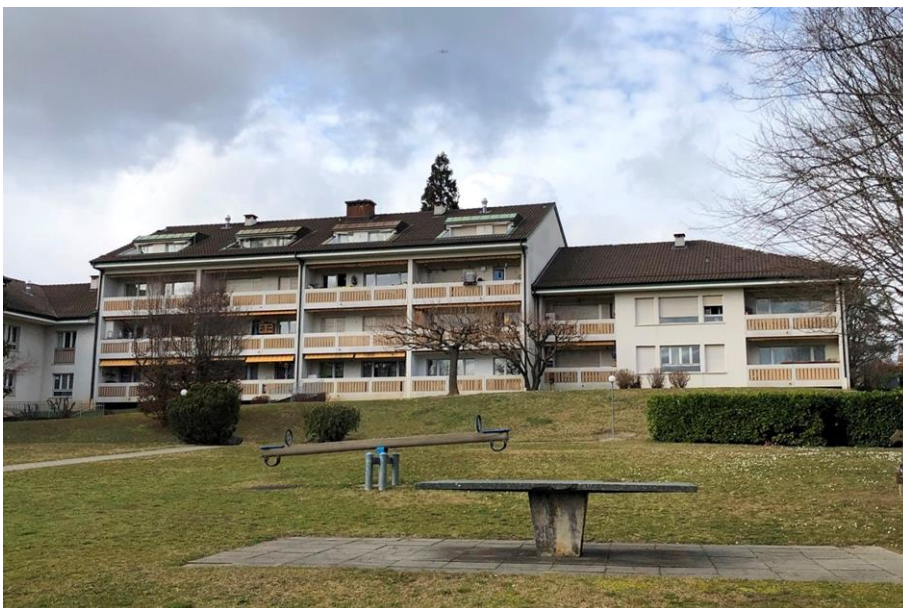
À Bernex-Sézenove, Implenla rénovera et surélèvera douze bâtiments datant de 1976, en misant sur une enveloppe isolante ménageant les ressources ainsi que sur un système de chauffage à haute performance énergétique. (Image : Implenla)
