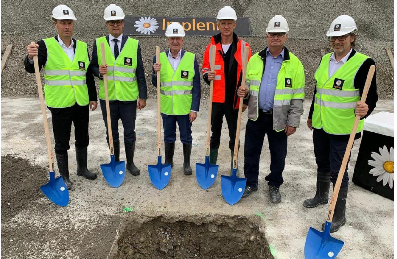
Ont posé, ensemble, la première pierre du projet innovant KIM inno-living (de g. à d.) : Marino Küng, responsable Gestion de construction, Swiss Life ; Adrian Wyss, responsable de la Division Développement, Implen ; Paul Stocker, chef de projet du maître d'ouvrage, Swiss Life ; Amadeus Dorsch, associé du bureau BDE Architectes ; René Lutz, chef de projet KIM, Implen, et Maximilian Müller, chef d'exécution, Implen. (Photo : Implen)
