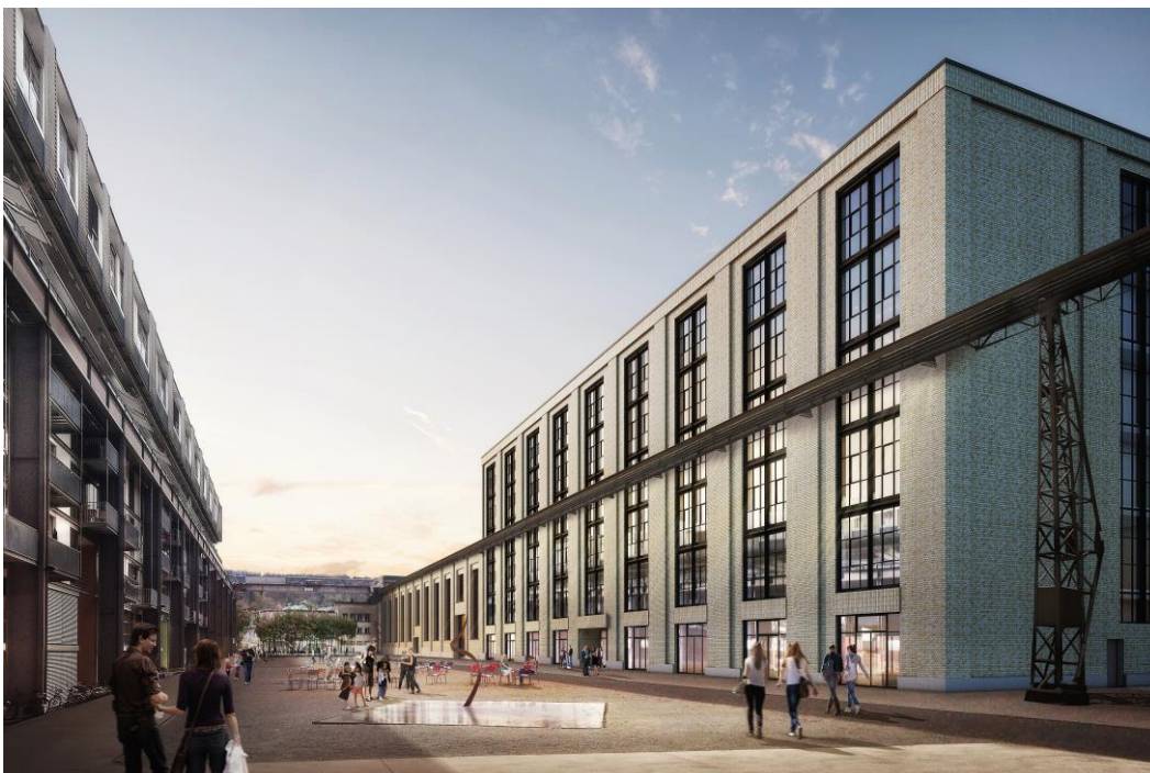
Der Bau des Hauses Adeline-Favre durch Implen als Totalunternehmerin liegt genau im Zeitplan. Es wird das grösste Ausbildungszentrum für Ergo- und Physiotherapie, Hebammen und Pflege der Schweiz.
