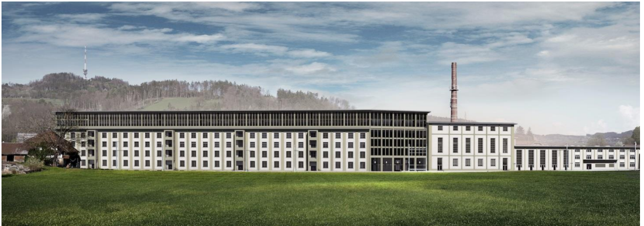
Im bernischen Deisswil lässt Implenla eine ehemalige Kartonfabrik zum Bernapark mit Wohnungen und Gewerbeflächen werden. (Bild: GHZ Architekten AG/Truc Konzept und Gestaltung)
