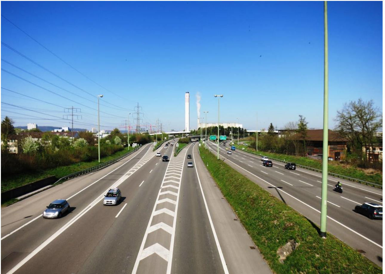
Un consortium placé sous la direction d'Implenia va rénover l'A1 entre Zurich-Est et Effretikon. (Photo : Implenia)
