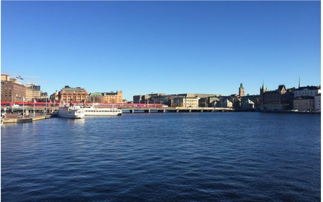
Implenia saniert und ersetzt Brücken und Tunnel für die Bahninfrastruktur im Herzen von Stockholm. (Bild: Implenia)
