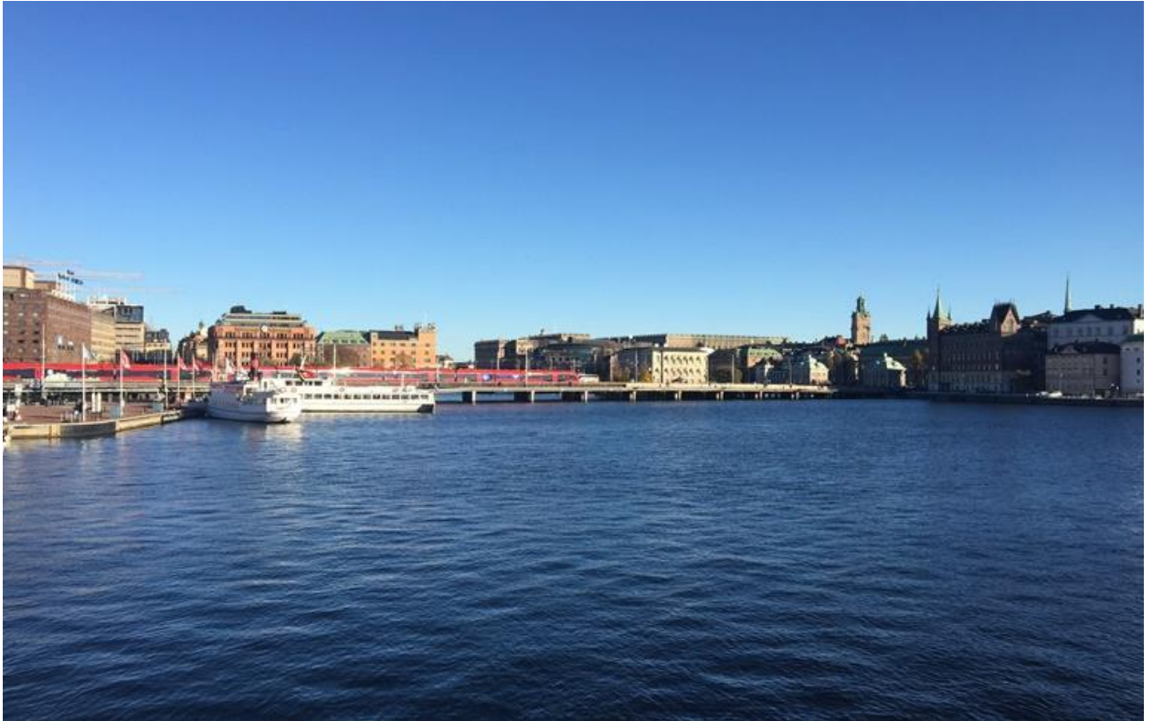
Implenia rénove et remplace des ponts et des tunnels de l'infrastructure ferroviaire au cœur de Stockholm. (Photo: Implenia)
