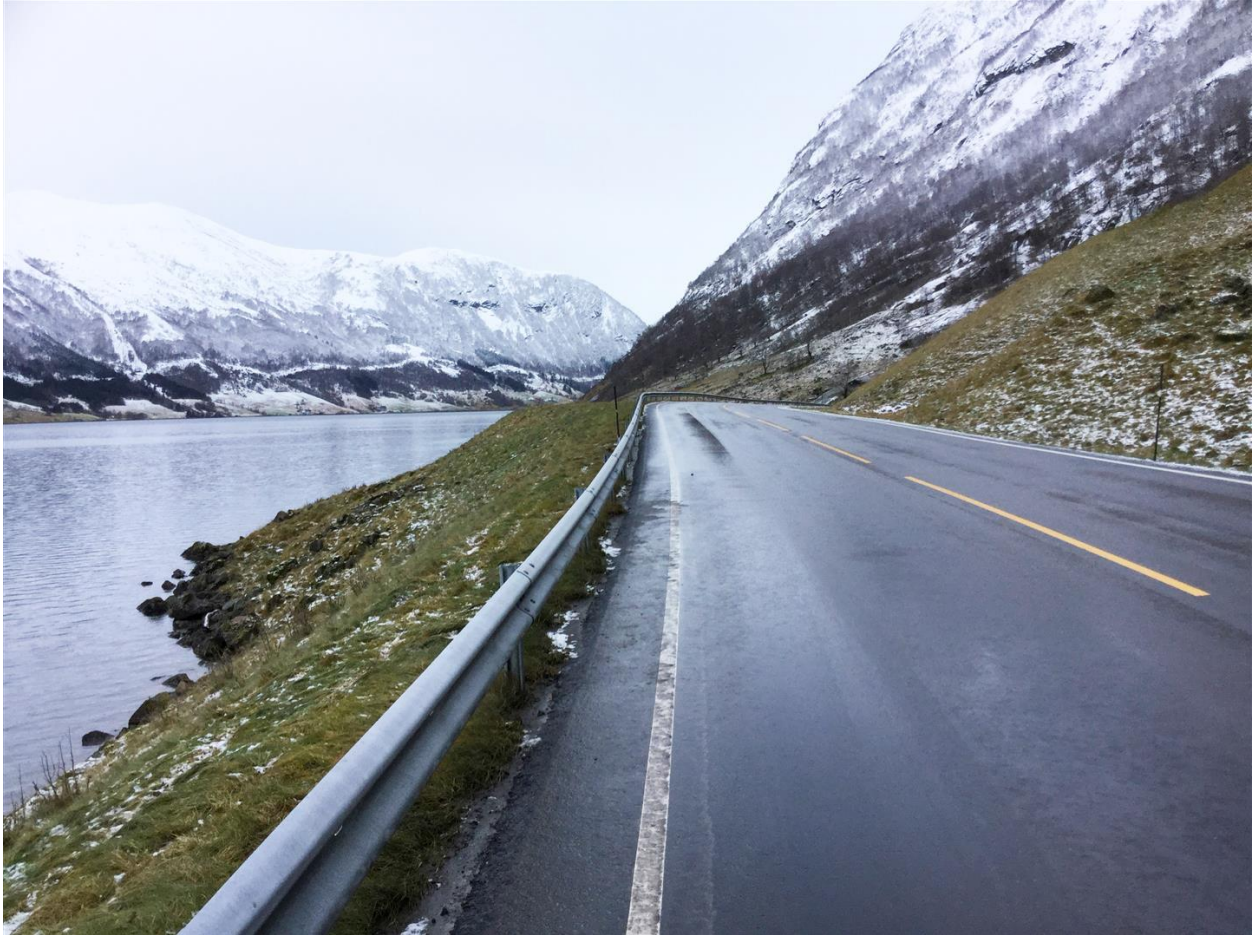
En Norvège, Implenla a obtenu l'attribution d'un lot supplémentaire de la liaison routière E39 entre Bergen et Trondheim. (Photo: Implenla)
