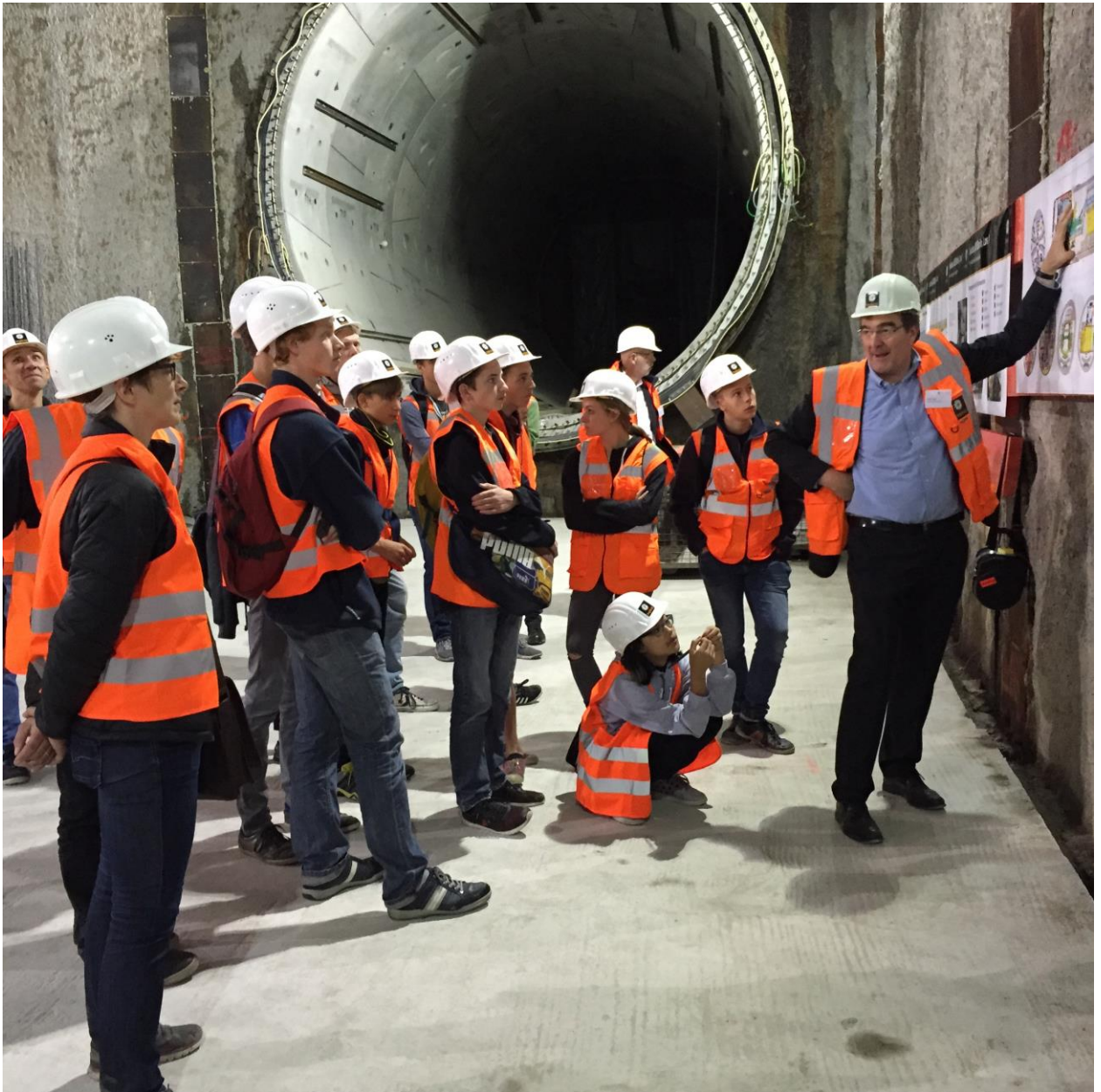
Implenia Tag der Industrie auf der U5-Baustelle in Berlin: Implenias bietet Schülern und Studenten regelmäßig die Möglichkeit, einen Blick hinter die Kulissen zu werfen. (Foto: Implenias AG)
