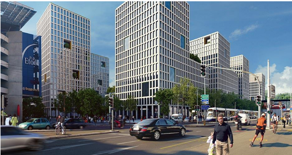
L'un des plus importants projets immobiliers de la région de Genève sortira de terre de part et d'autre de la future station Lancy – Pont-Rouge. (Source: CFF)
