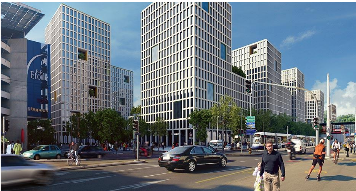
Rund um die Bahnstation Lancy -Pont-Rouge entsteht eines der grössten Immobilienprojekte in der Region Genf. (Quelle: SBB)
