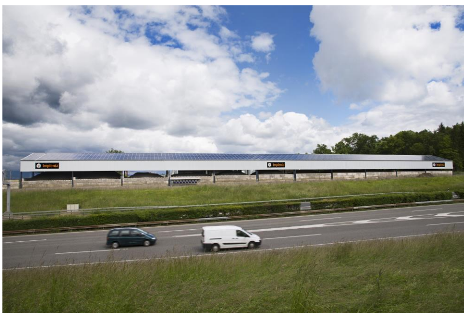
L'installation photovoltaïque de 2500 m 2 sur le toit de la centrale d'enrobés est visible depuis l'autoroute A1. Elle produit annuellement plus de 300 000 kWh d'énergie solaire. (Image : Implenla)
