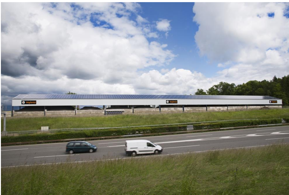
Von der Autobahn A1 aus ist die 2500 m 2 grosse, auf dem Dach des Belagswerks installierte Photovoltaikanlage sichtbar. Sie produziert jährlich mehr als 300'000 kWh Solarstrom. (Bild: Implenia)
