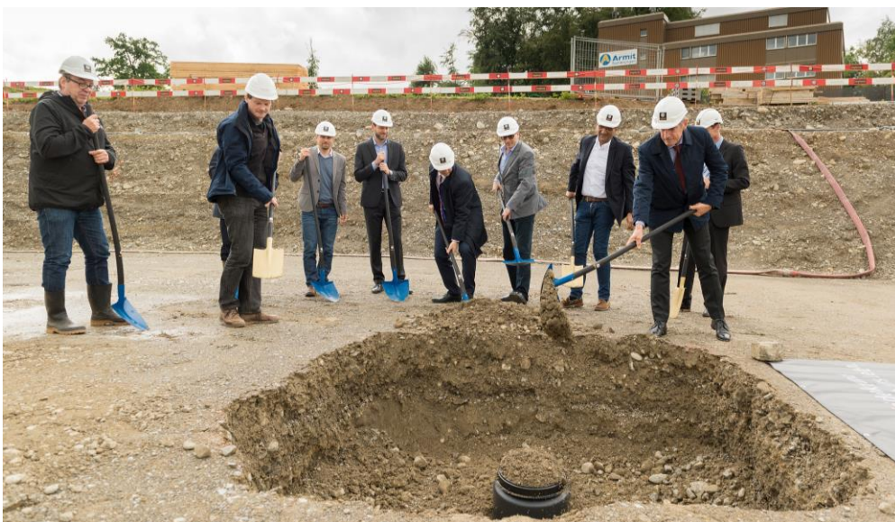
Feierliche Grundsteinlegung für das Gewerbe- und Freizeitzentrum Gümligenfeld Center. (Bild: Implenia)
