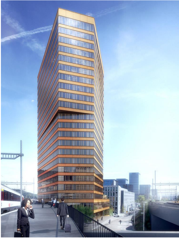
Hier am Bahnhof Oerlikon erstellt Implenia den 80 Meter hohen Andreasturm. (Bild: SBB Immobilien; Gigon/Guyer)
