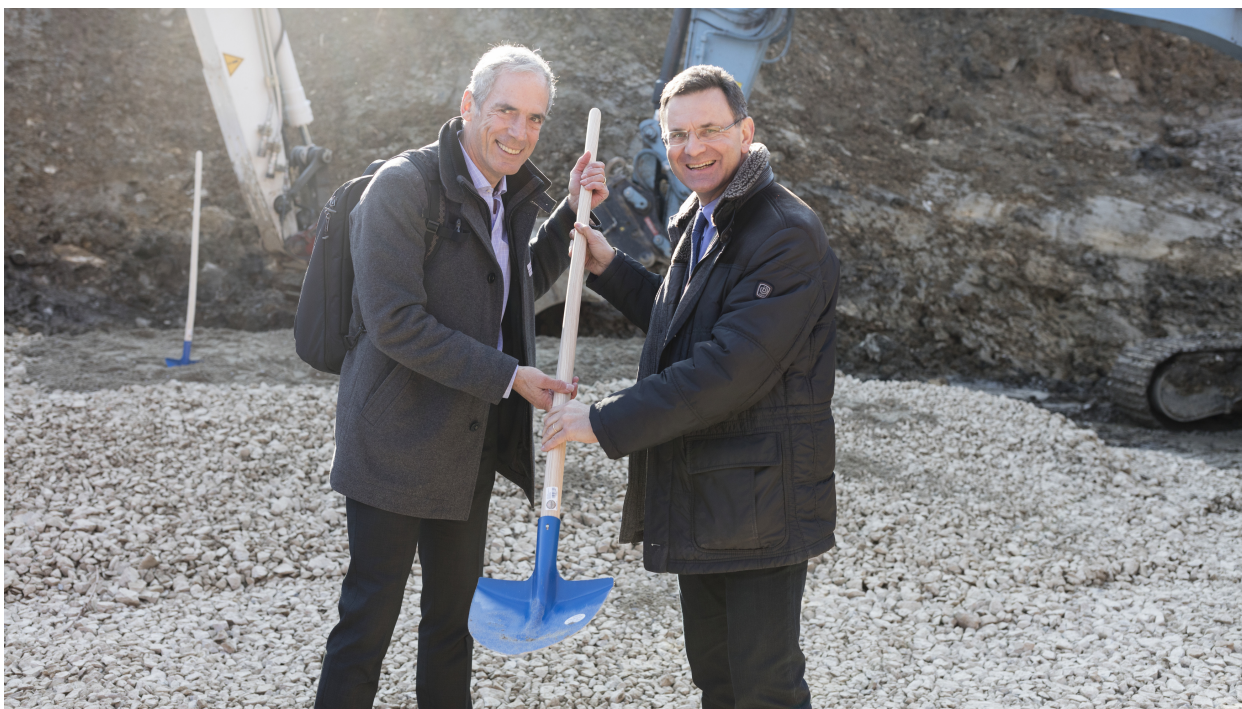
Spatenstich für den Neubau der SBB des Bözbergtunnels am 9. März 2016: Philippe Gauderon Leiter SBB Infrastruktur (rechts), mit Anton Affentranger, CEO Implenia, (links). Bild: SBB/Gaetan Bally
