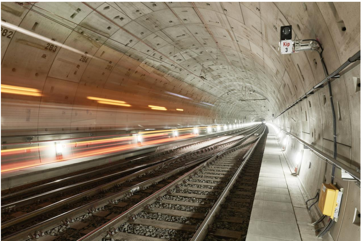
Avant l'inauguration: aperçu du «tube» de la nouvelle «Wehrhahn-Linie» du métro léger de Düsseldorf, réalisée par Implen SA en tant qu'entreprise générale pour le lot 1. (Photo: Bernd Schumacher)
