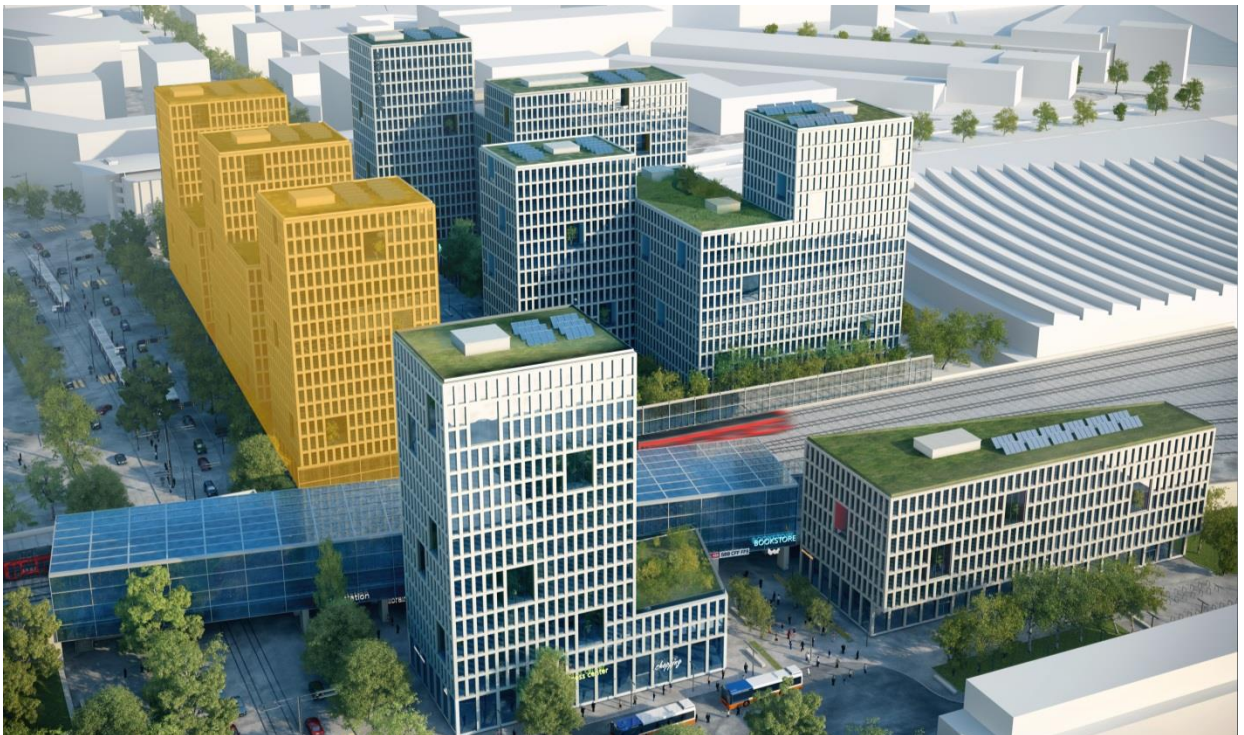
Implenia zeichnet für die erste Bauetappe, das Bau Feld B1 (gelb markiert), verantwortlich. Hier entstehen bis Herbst 2018 Flächen für Büroutzungen. (Quelle: SBB)
