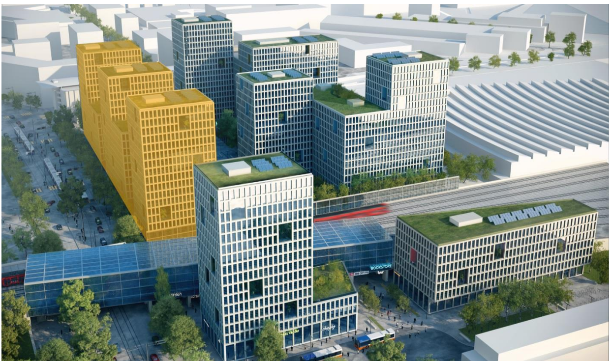
Implenia assume la responsabilité de la première étape de construction, à savoir le lot B1 (marqué en jaune). D'ici à l'automne 2018, elle y construira des surfaces administratives. (Source: CFF)
