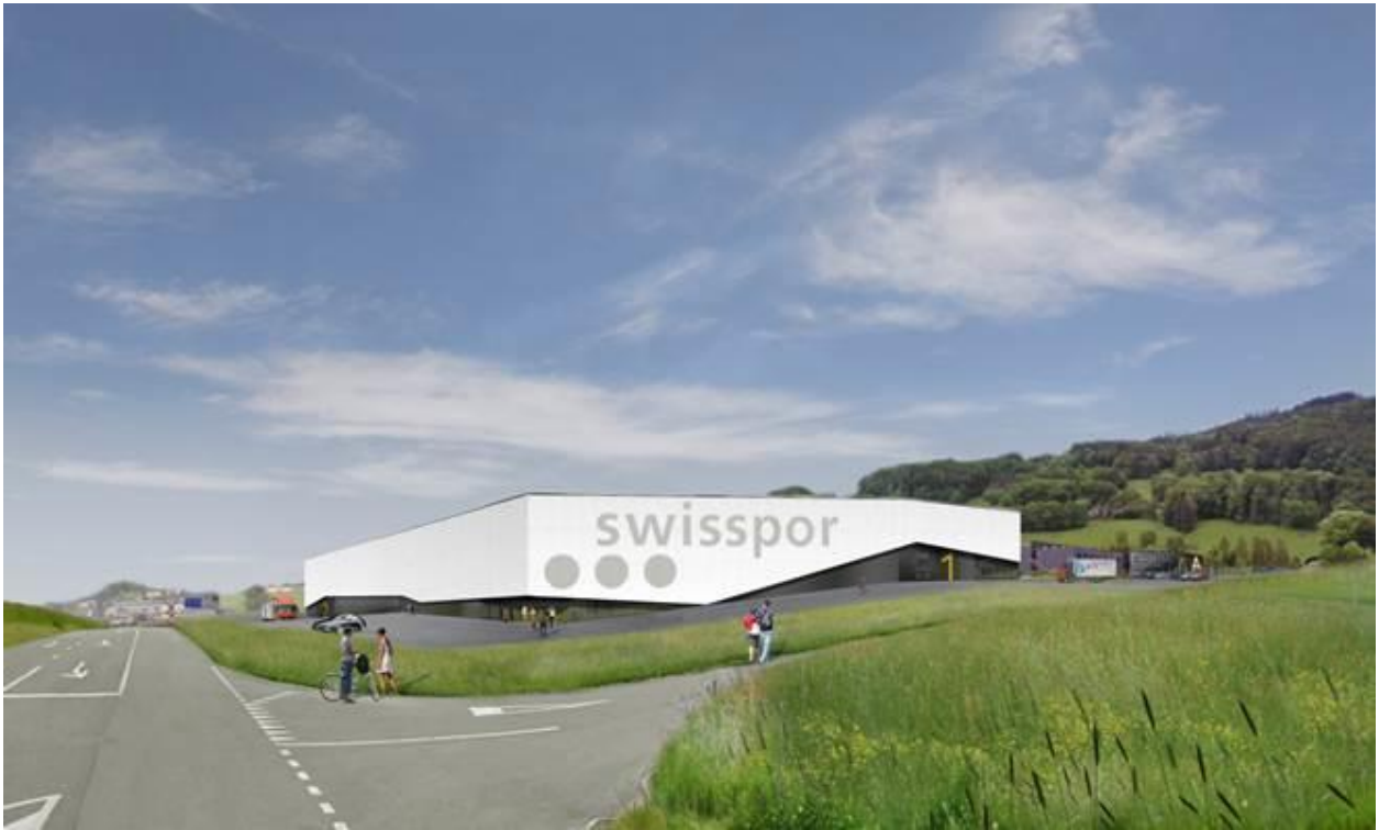
Die zufällig wirkende, farbliche Trennung zwischen dunkel und hell lässt die künftige Produktionsstätte von swisspor in Châtel-Saint-Denis leicht erscheinen.
