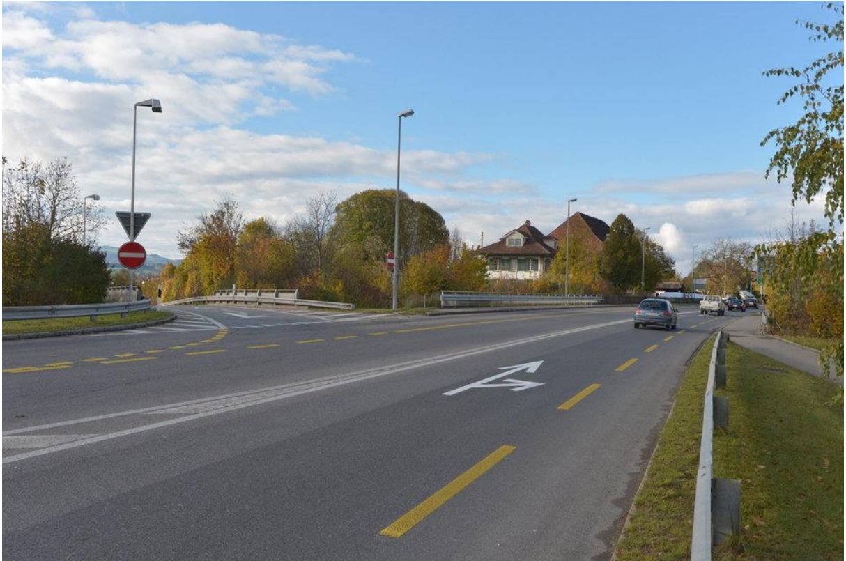
Der Bypass Thun Nord soll die Thuner Innenstadt und die Bernstrasse vom Verkehr entlasten (Bild: Die Ausfahrt vom Autobahnzubringer (links); Quelle: Patric Spahni)
