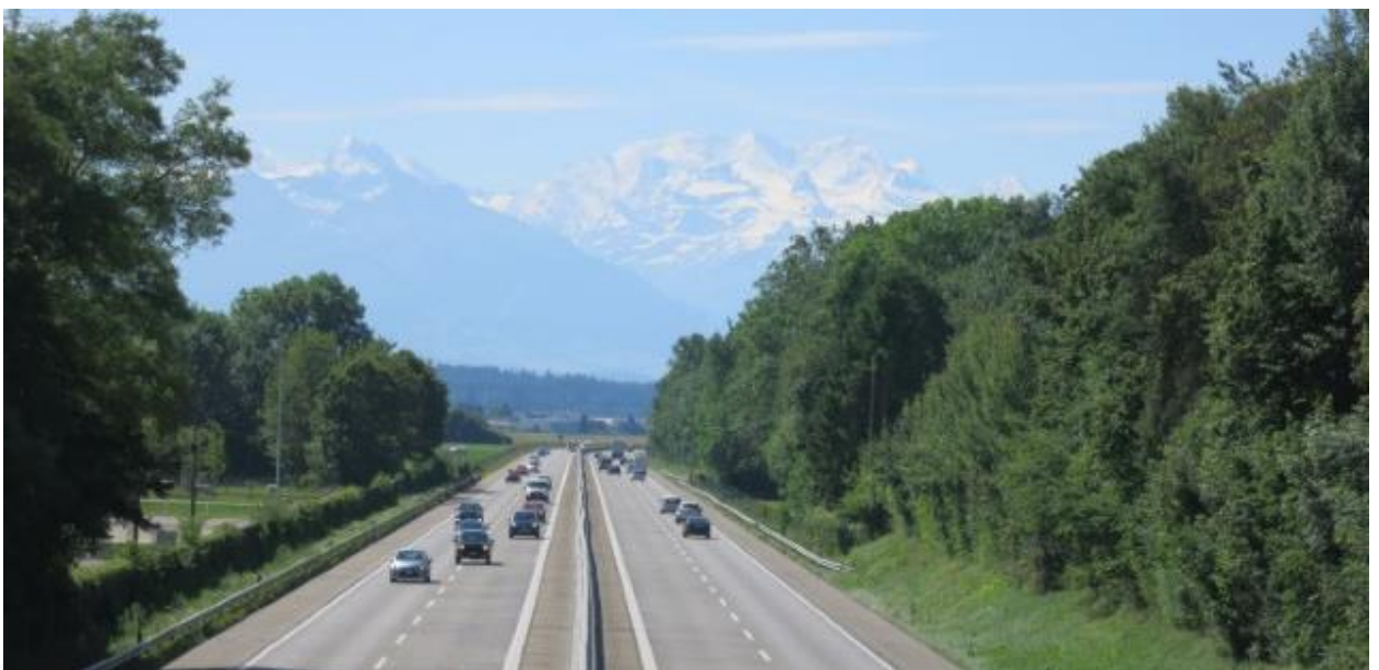
Bis 2016 erneuert Implenia innerhalb der ARGE KiRu den 10 Kilometer langen Autobahnabschnitt zwischen Rubigen und Kiesen.
