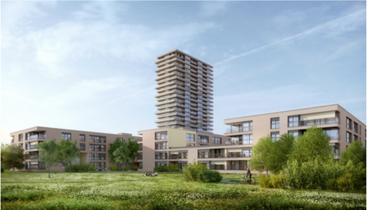
Der 75 Meter hohe „helvetia tower“ bietet ab 2016 Platz für 124 attraktive Wohnungen mit einzigartiger Aussicht über Pratteln und die Rheinebene.
