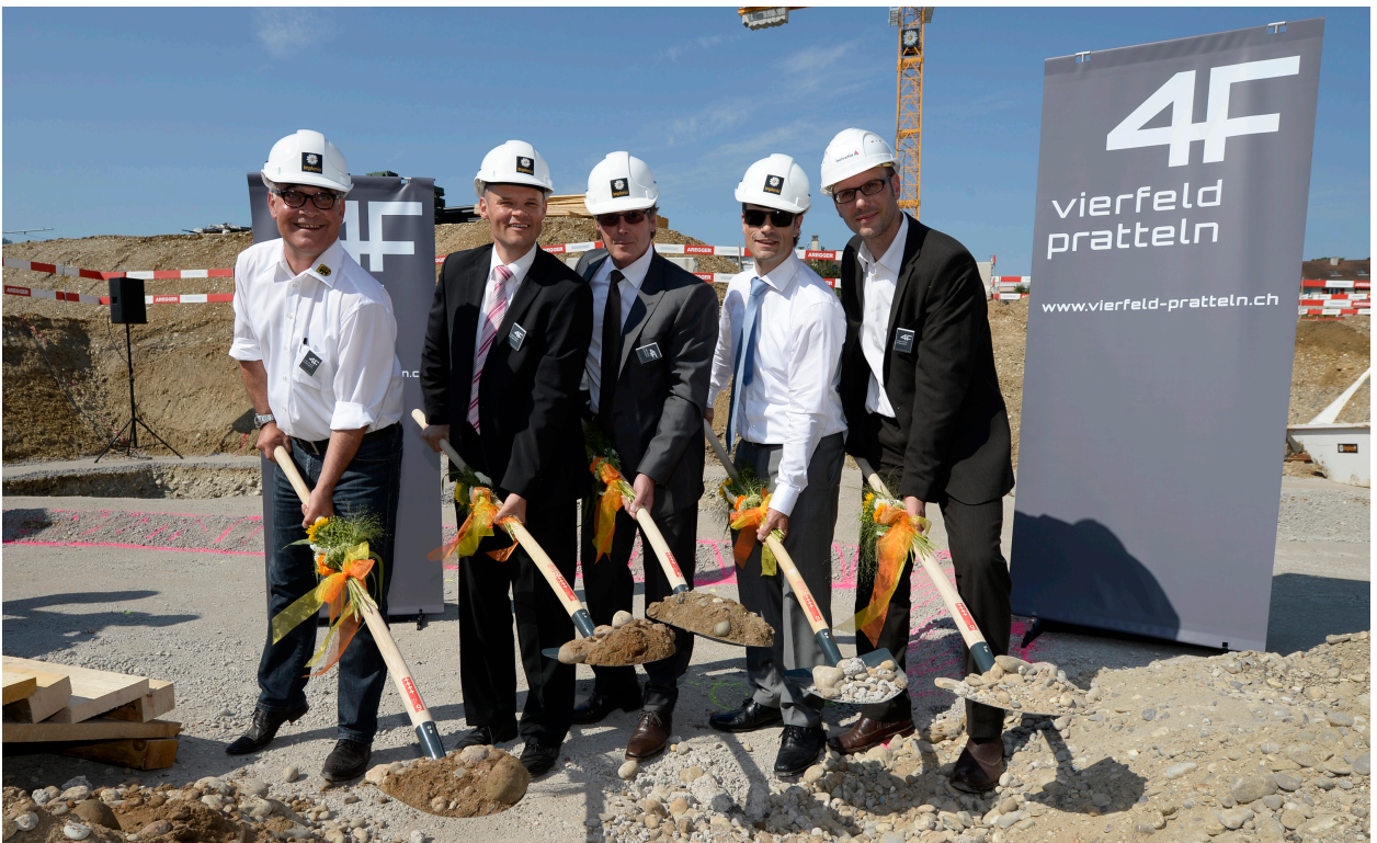
Projektentwicklerin Mettler2Invest hat heute in Pratteln gemeinsam mit den Investoren Helvetia Versicherungen, Migros-Pensionskasse und Mobilier Assesst Management sowie Totalunternehmerin Implenia feierlich den Grundstein für das „vierfeld“-Areal gelegt.
