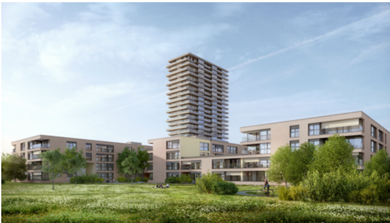
D'une hauteur de 75 mètres, la «helvetia tower» proposera, à partir de 2016, 124 logements superbes bénéficiant d'une vue imprenable sur Pratteln et la vallée du Rhin.
