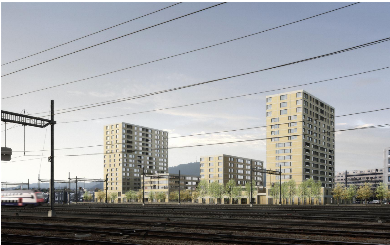
Implenia réalise pour les CFF, maître d'ouvrage, un grand projet à Zurich Altstetten.
