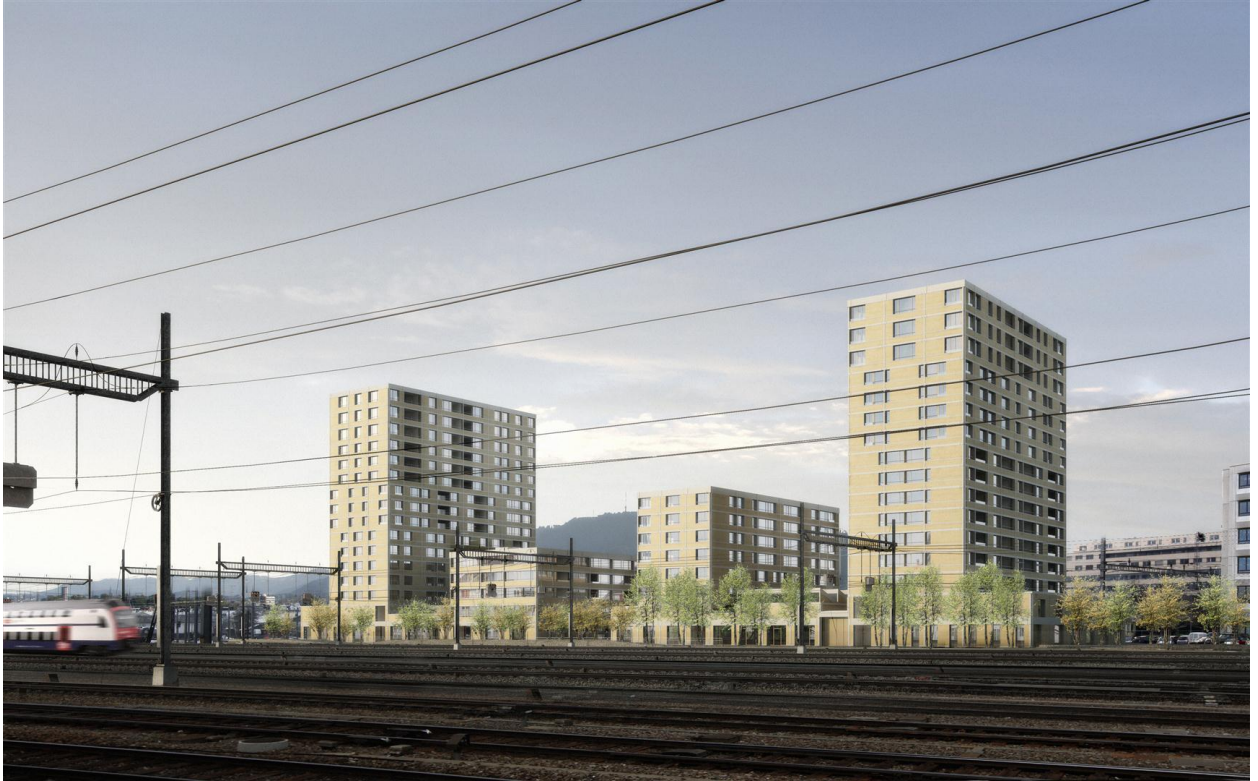
Implenia realisiert für die Bauherrin SBB ein Grossprojekt in Zürich Altstetten.
