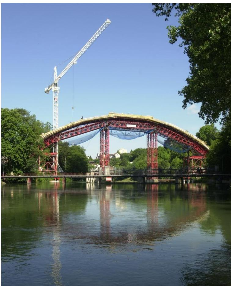
Les échafaudages de soutien sont utilisés comme structures auxiliaires notamment pour le coffrage et le bétonnage dans la construction de ponts en béton.
