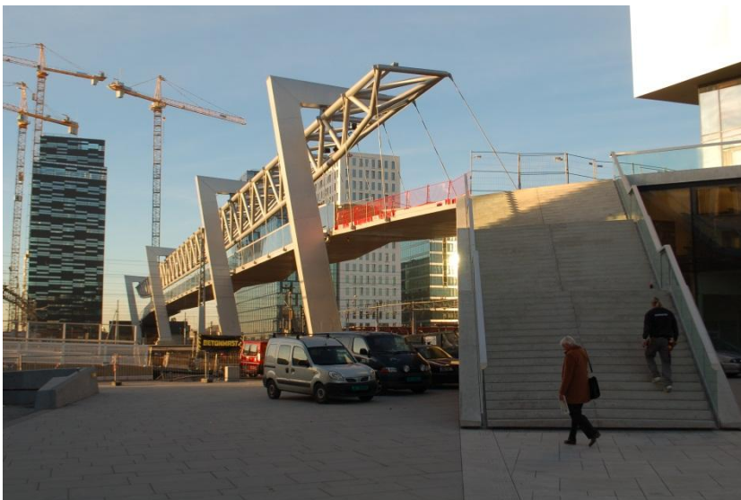
Implenia s'est vu décerner l'«European Bridges Award» pour la passerelle piétonnière «Acrobats» dans le centre d'Oslo.
