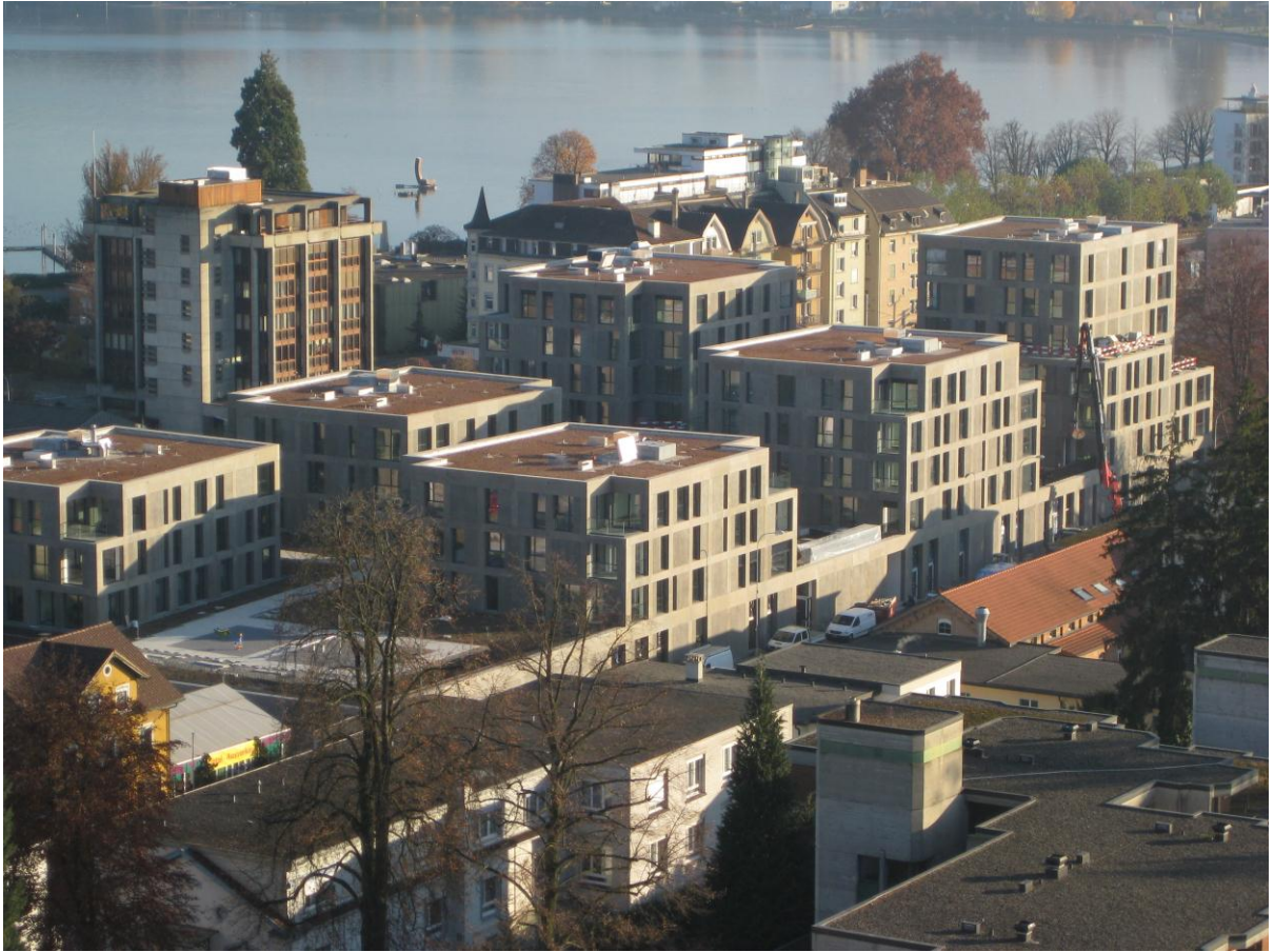
Das Projekt Rosengarten in Arbon wurde von Implenia unter dem Aspekt des nachhaltigen Bauens entwickelt, geplant und realisiert.
