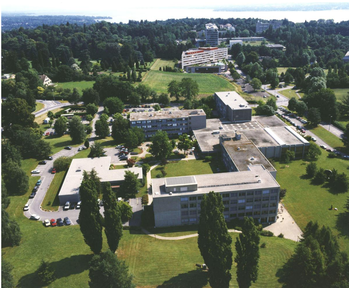
Luftaufnahme des Grundstücks mit dem Ökumenischen Zentrum in Grand-Saconnex (Genf), das über die nächsten fünf bis zehn Jahre entwickelt wird. Das Areal umfasst 34'000 Quadratmeter.
