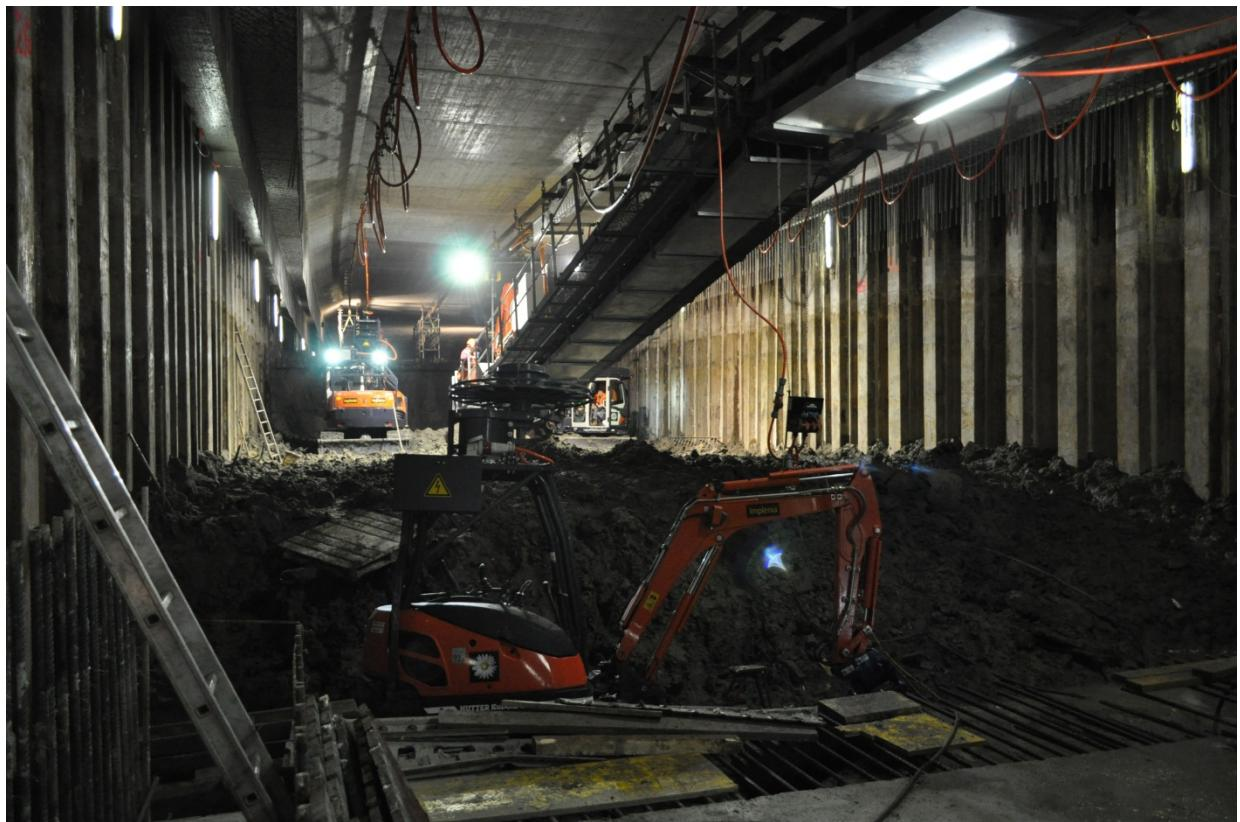
Tieflegung Zentralbahn Luzern: Das erstmalig schweizweit angewendete Deckelbauverfahren unter Druckluft brachte zwei entscheidende Vorteile. Einerseits konnte das Grundwasser geschont und andererseits der Rohbau ein Jahr früher als geplant fertig gestellt werden.
