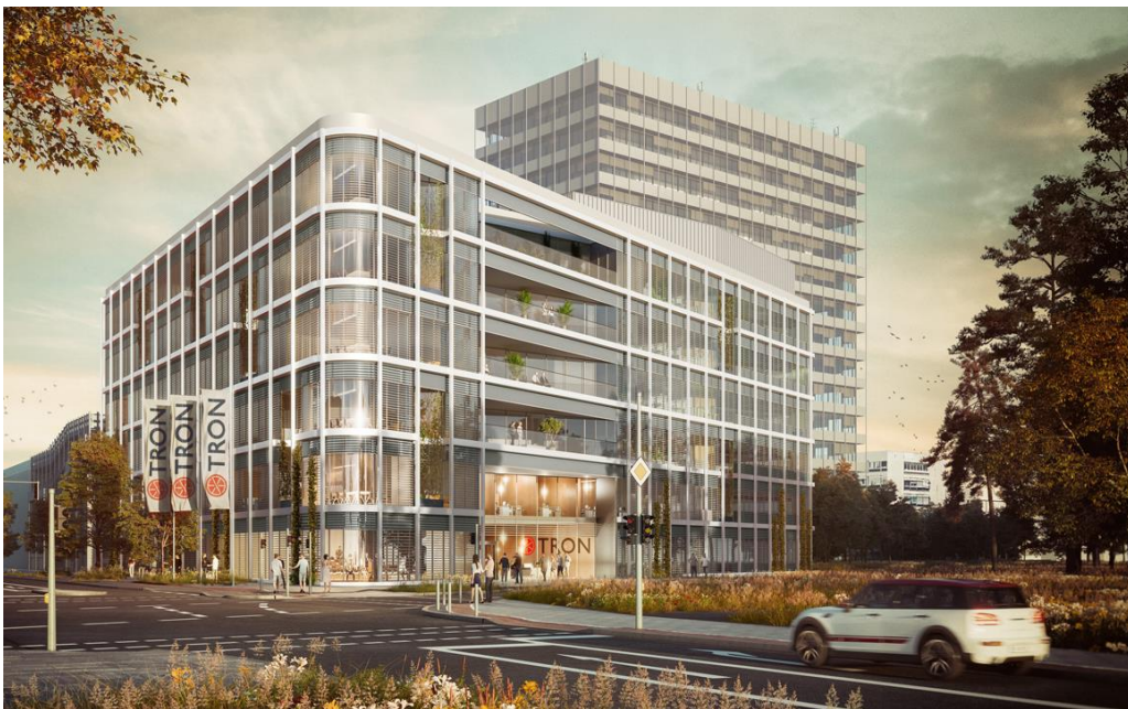
Construction neuve du bâtiment de recherche TRON pour la recherche médicale de pointe à Mayence (image : ©NICKL & PARTNER ARCHITEKTEN AG).
