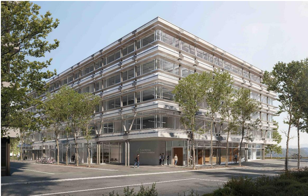
Neue Geschäftsstelle des SNF in Bern: Für Dach und Fassade sind Photovoltaik-Module vorgesehen. Lamellen an der Fassade, sogenannte Brise Soleil, schützen vor Hitze (Bild: ©Penzel Valier AG).
