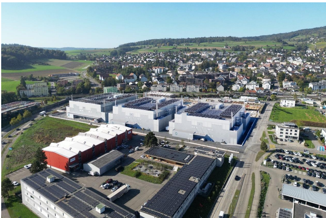
Implenia construit deux autres centres de données pour le Green Metro-Campus à Dielsdorf, près de Zurich (image : © zvg. bfarchitekten.ch).
