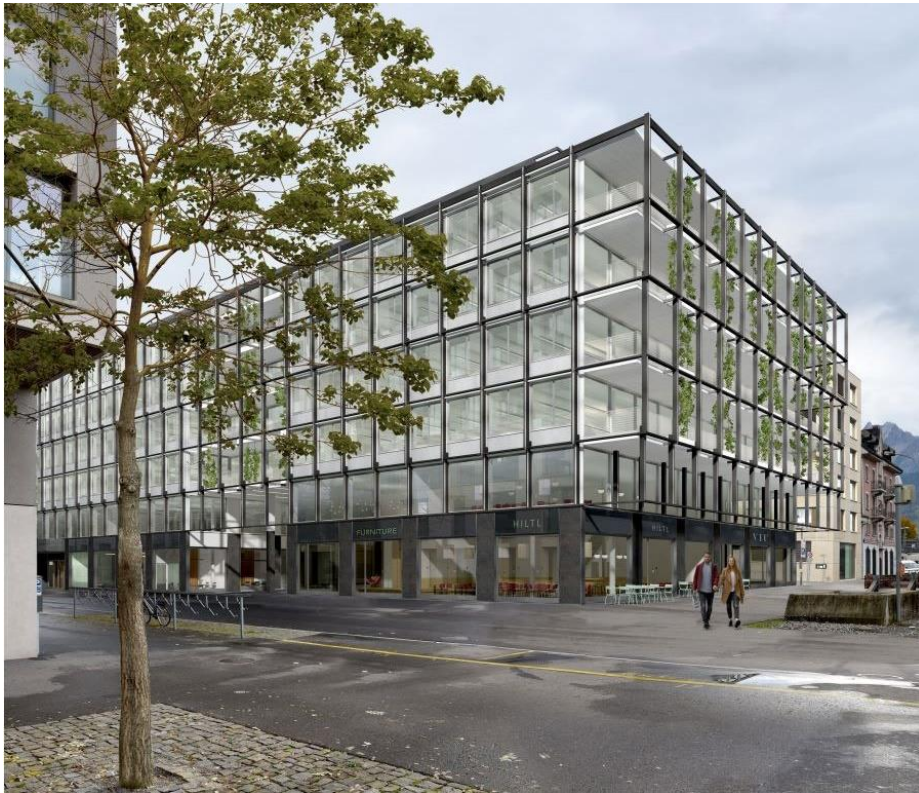
Rösslimatt : bâtiment commercial et de bureaux idéalement situé près de la gare de Lucerne (image : © CFF Immobilier).
