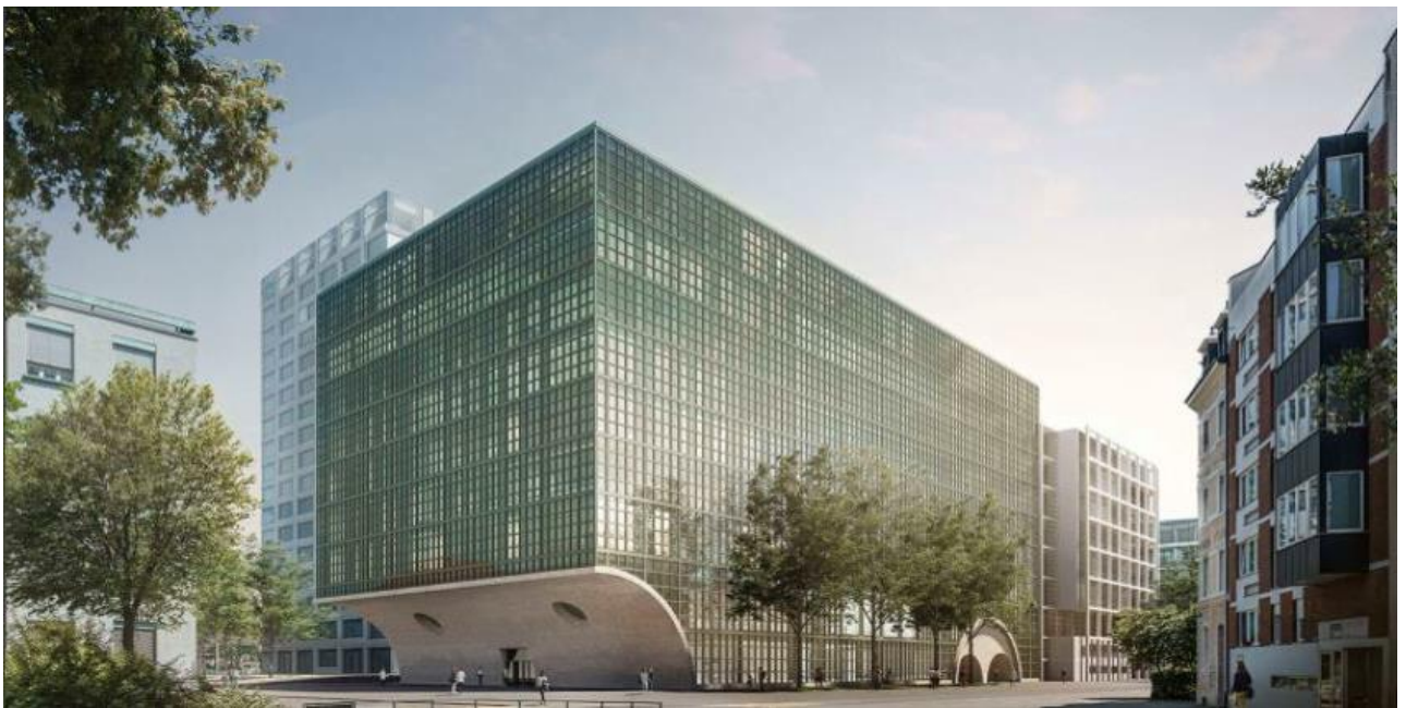
Laborneubau für das Departement Biomedizin der Universität Basel (Bild: ©Burckhardt+Partner).
