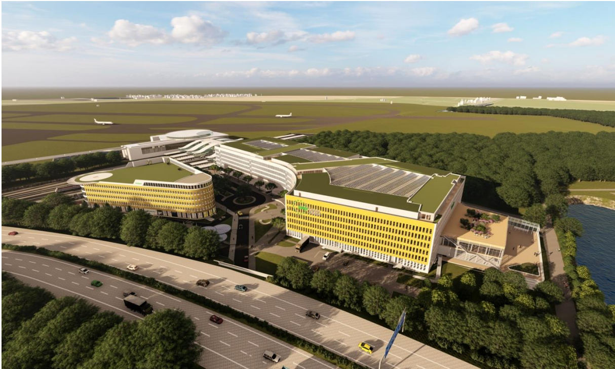
EUREF-Campus Düsseldorf: Implenía baut den ersten Nachhaltigkeits- und Innovationscampus in Nordrhein-Westfalen (Bild: ©EUREF).
