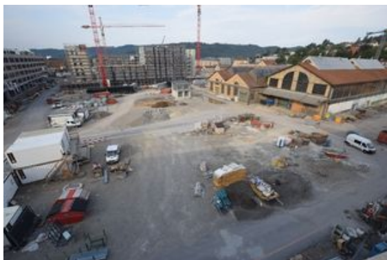
Haus Krokodil im Rohbau, August 2019
