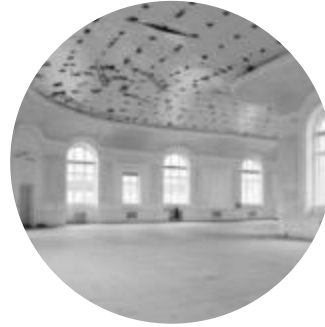
Tüchler Ausbau, Interior/Dry Construction
