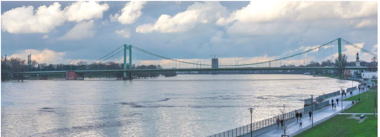
Le pont Mülheimer Brücke au nord de Cologne sera rénové de fond en comble par Implenia. (Photo: Björn Krause)
