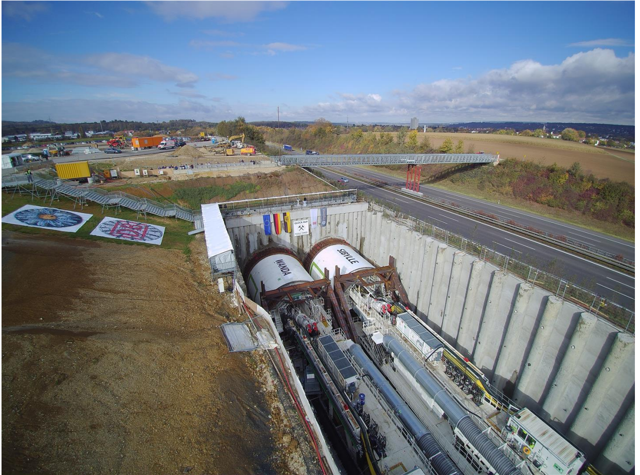
Les deux tunneliers, Wanda et Sibylle, ont été baptisés solennellement avant de pouvoir se mettre au travail. (Photo : Jürgen Stresius)
