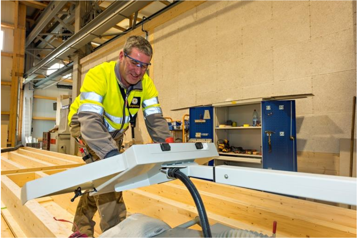
Implenia investit dans la construction en bois: la nouvelle halle de production à Rümliang utilise des processus entièrement numérisés. (Photo: Implenia)
