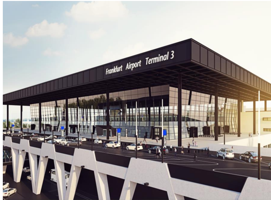
Fassadentechnik: Airport Terminal 3, Frankfurt, Deutschland
