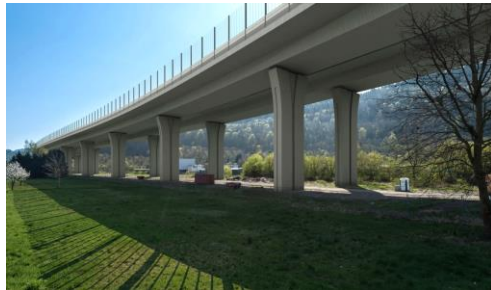
Talbrücke Sechshelden, Deutschland
