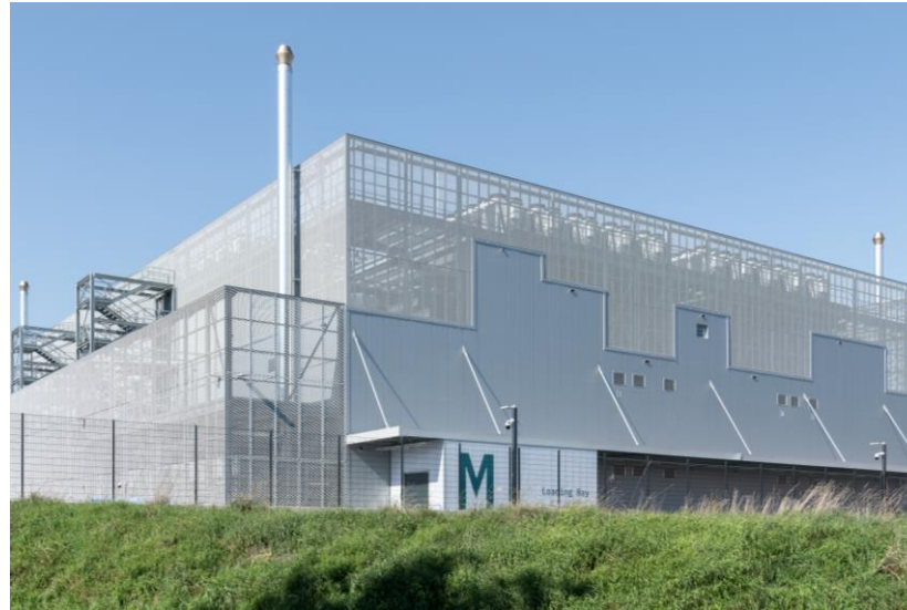
Datacenter Metro-Campus, Zürich, Schweiz
