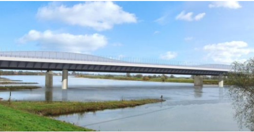
BBV Systems (Spannverfahren): Elbbrücke Wittenberge, Deutschland
