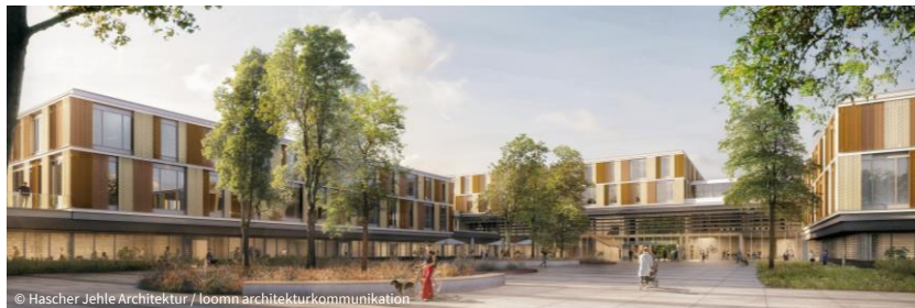
Fassadentechnik: Heidekreis-Klinikum, Bad Fallingbostal, Deutschland
