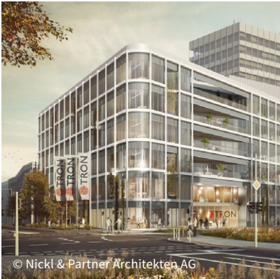
«TRON», Mainz, Deutschland: Unter der technischen Federführung von Implenia entsteht bis 2027 zusammen mit zwei ARGE-Partnern das neue, rund 10'000 m 2 grosse medizinische Forschungsgebäude auf dem Gelände der Universität Mainz.
