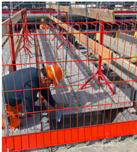
Vormontierte Absturzsicherung Diese vormontierte Geländerlösung sorgt für mehr Sicherheit bei der Installation von Zwischendecken.
