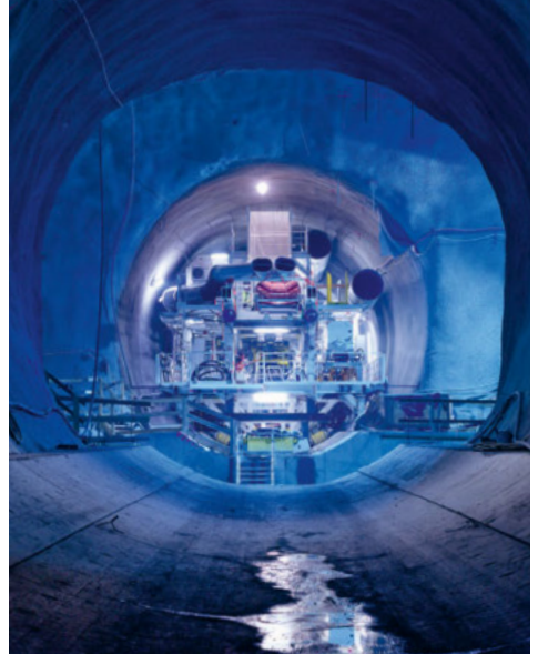
Beim Semmering-Basistunnel, Los 2.1, «Tunnel Frörschnitzgraben», nimmt die erste von zwei Tunnelbohrmaschinen ihren Betrieb auf.
