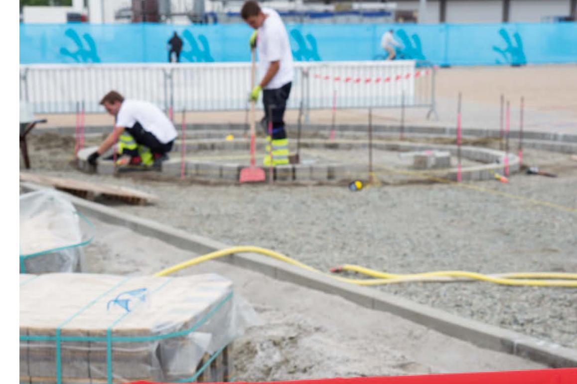
Dominic. Trotz körperlicher Anstrengung geht es nicht ausschliesslich um Muskelkraft, sondern um Millimeter, um ein einheitliches Fugenbild, um saubere Linien, Ebenheit sowie korrekte Längen- und Höhenmasse.
